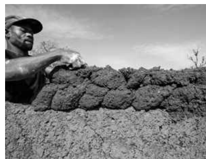
Fig. 41 Pose simultanée de deux assises en bauge à Malinda (photo T. Pelmoine)
